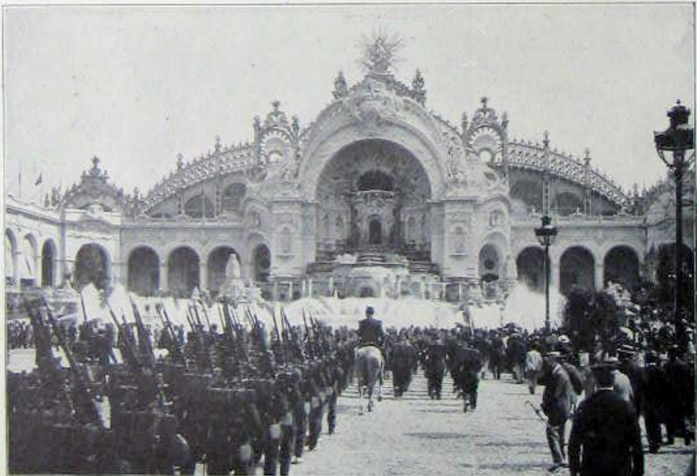
LE CHÂTEAU D'EAU
