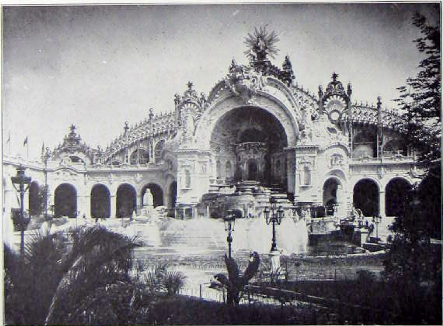
LE CHÂTEAU D'EAU
