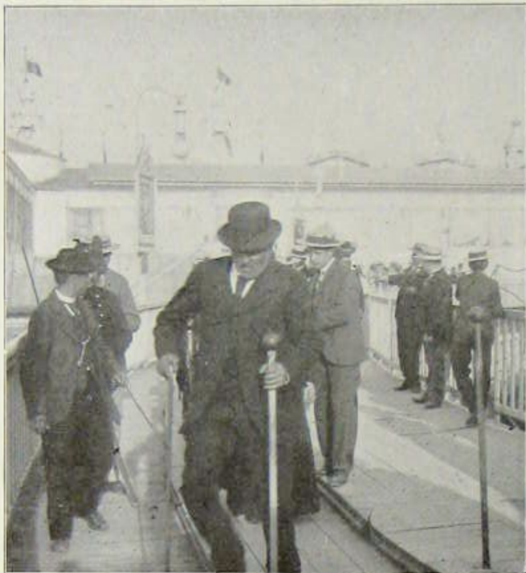
ROLLING ON THE TROTTOIR ROULANT
